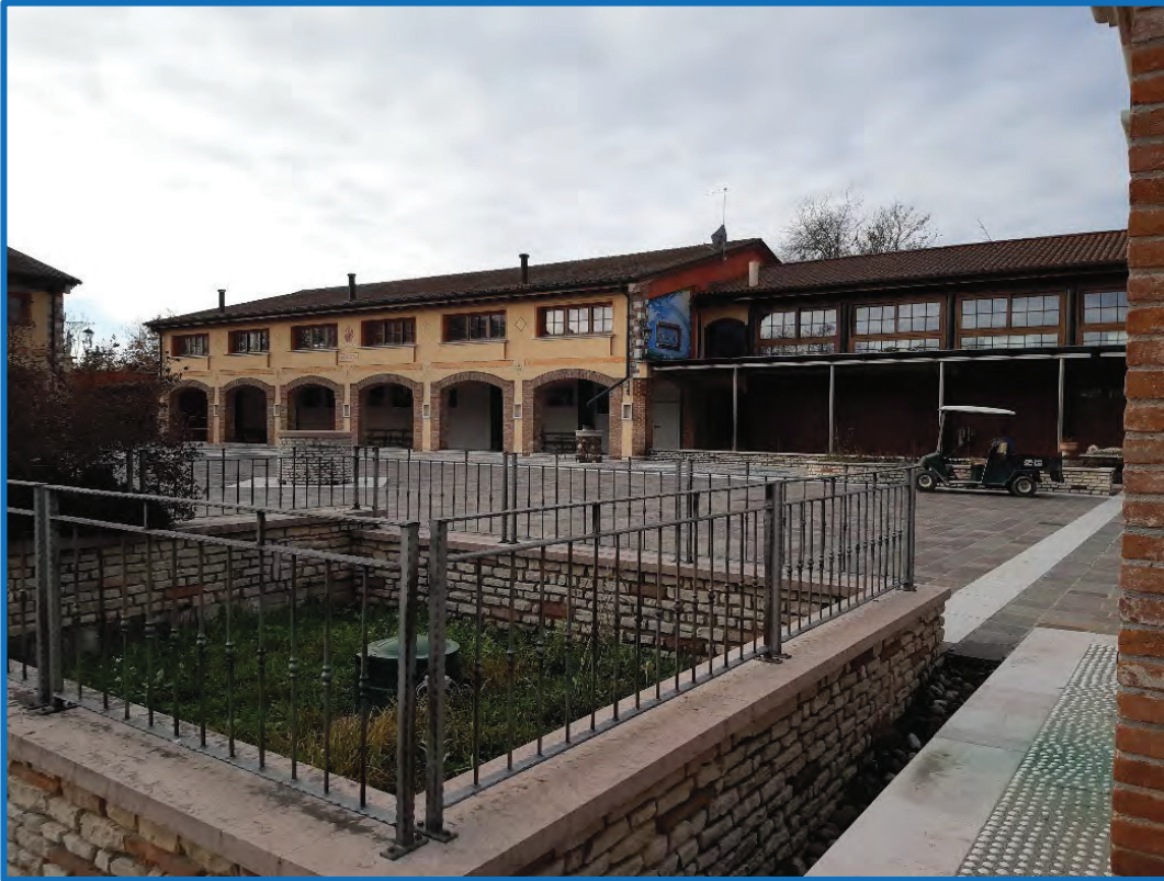
n° 3 - Particella Mn 432 – veduta della corte comune
