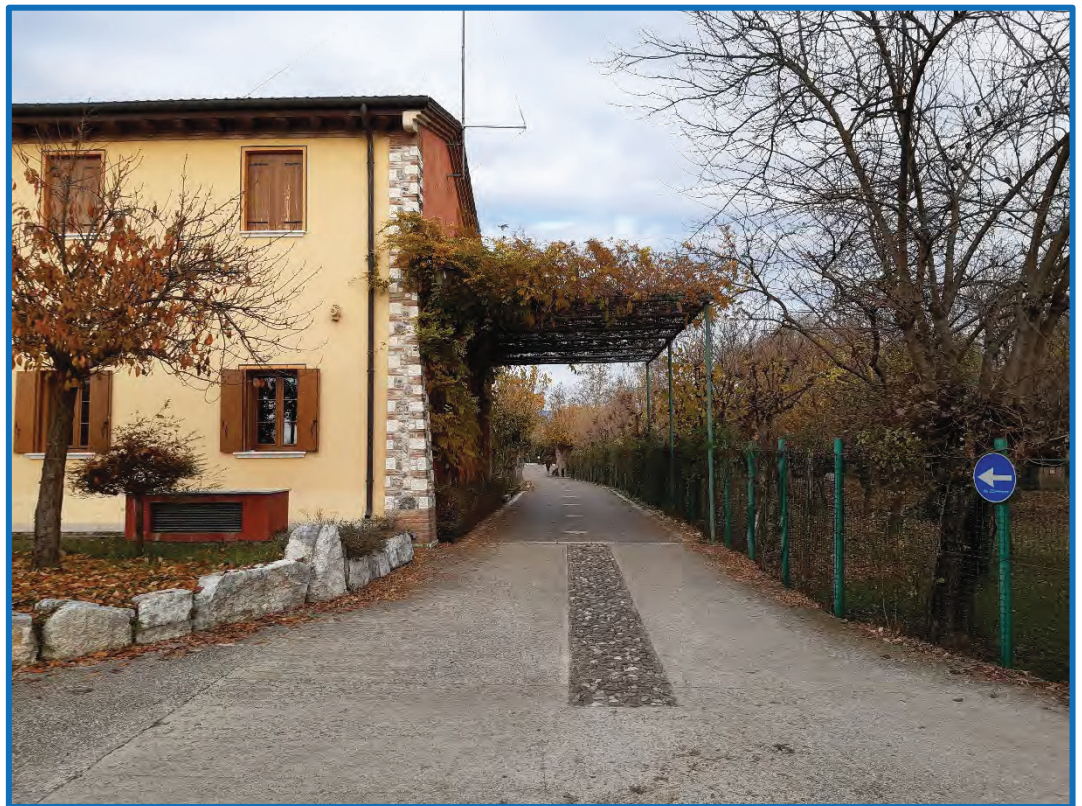
n° 2- Particella Mn 432 – accesso da via San Pietro
