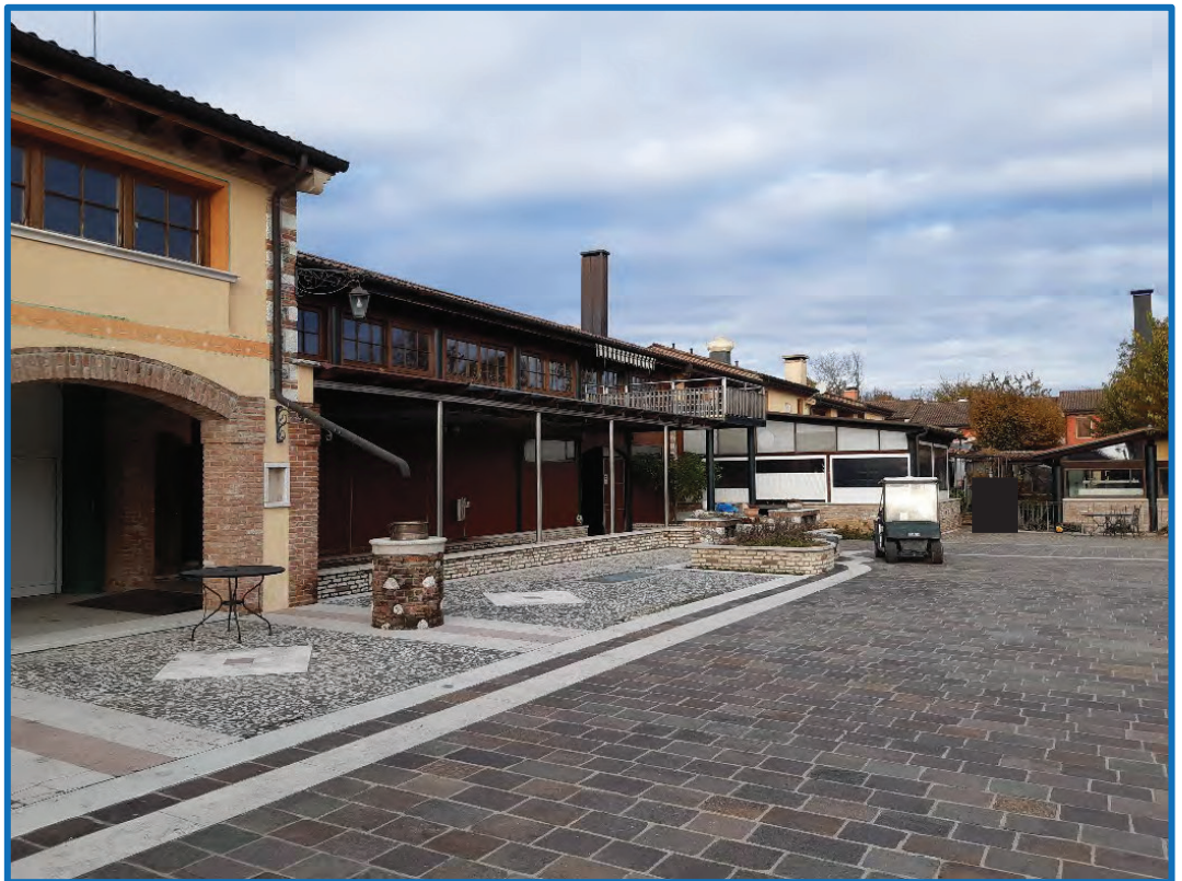
n° 4 - Particella Mn 432 – veduta della corte comune
